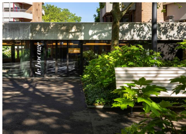
Restaurant le bocage, Oase im Gellert
